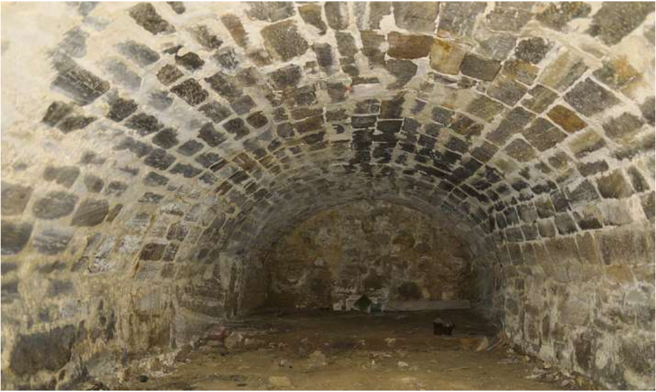
Der in Sandstein gehauene, sonst mit Sandsteinquadern gemauerte Gewölbekeller stammt vermutlich aus einer mittelalterlichen Vorgängerbauung.
