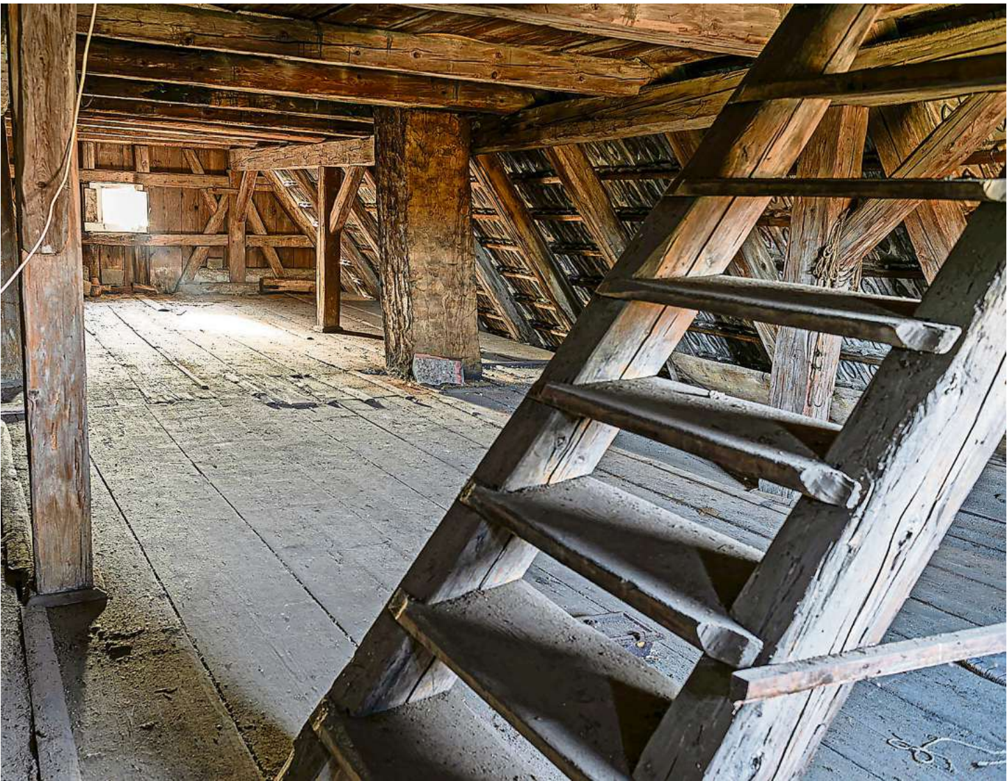
Mehrstöckiger Dachstuhl in der ehemaligen Gaststätte „Zum Schwanen“: Die kunstvolle Mischkonstruktion zeigt die außerordentlichen Fähigkeiten der Thurnauer Zimmerleute.
